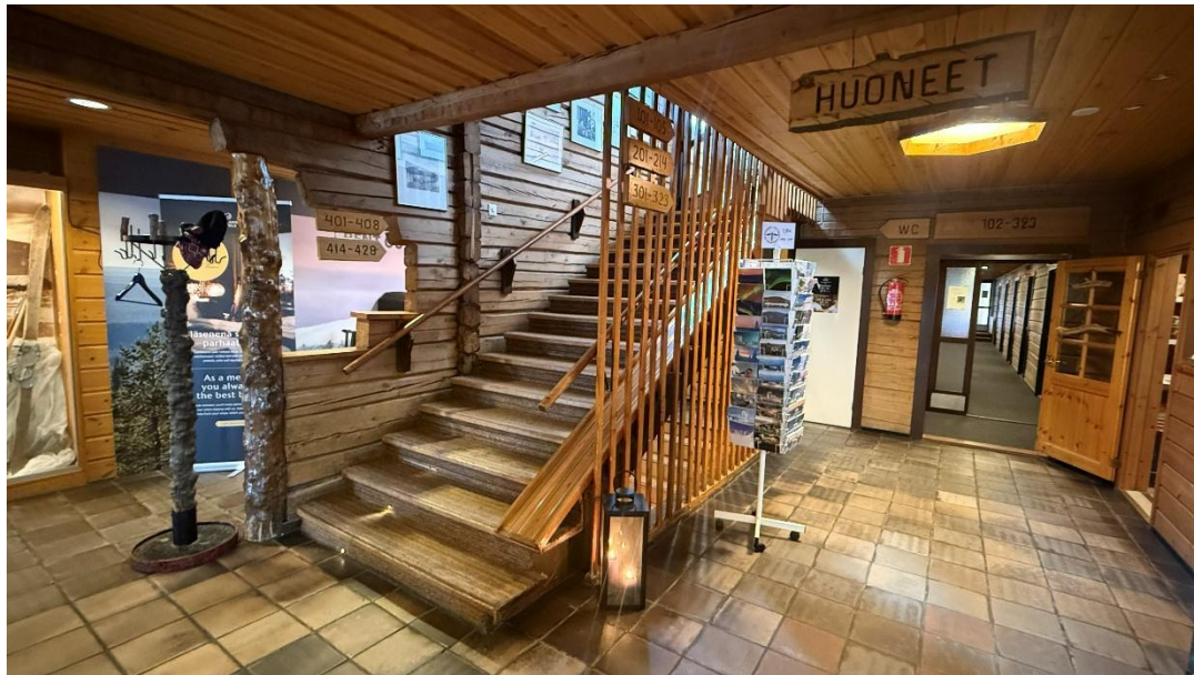
Näkymä aulasta. Portaan hirsiseinä on 1948 hotellin ulkoseinälinja. Interiöörin detalleja on säilynyt 1948 valmistuneilta rakennusosiltaan alkuperäisenä.
