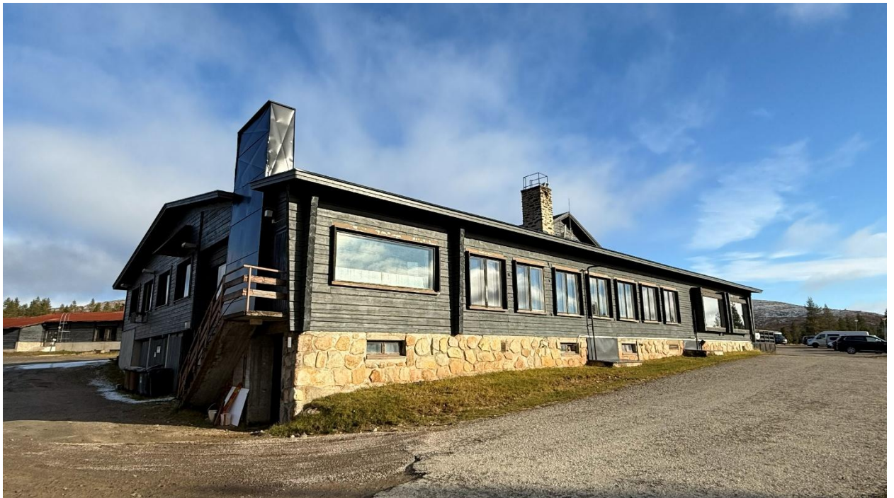
Ravintolasalin 1961 tehty laajennus toi päätyyn palohormin, poistumisportaan sekä suuren suorakaiteisen ikkunan. Palohormin pellitystä lukuun ottamatta nurkka on säilynyt alkuperäisessä asussaan.
