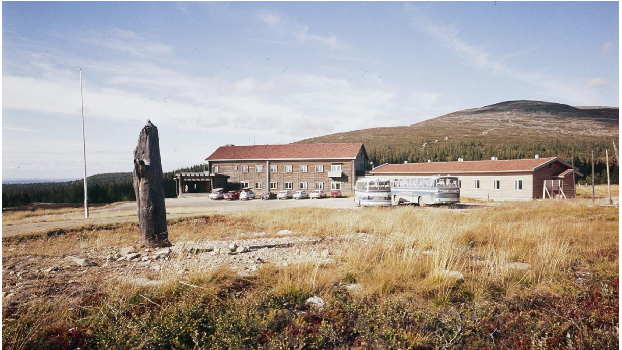
22. Hotelli Pallasta laajennettiin 1950-luvun puolivälissä yksikerroksisella lisäsiivellä. Alkuperäinen hirsinen päärakennus on kaksikerroksinen. Kuva: Pekka Kyytinen, 1955-1974, MVKK.
