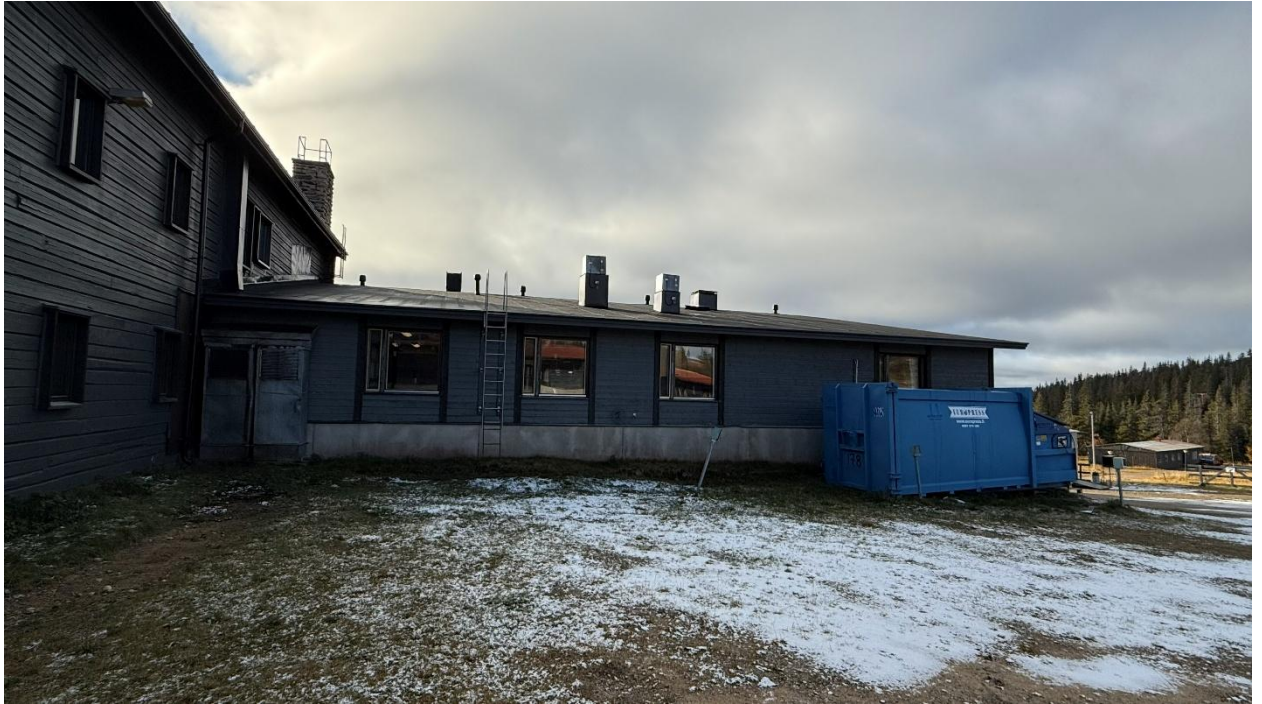
1988 tehdyn keittiölaajennuksen julkisivu.
