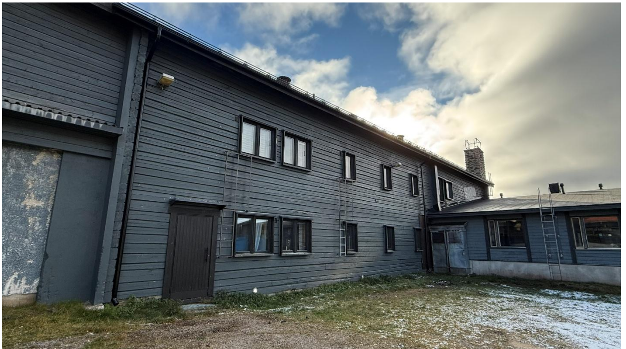
1948 hirsihotellin pohjoinen julkisivu. Kuvan etualalla olevan hirsisalvoksen vasemmalta puolelta alkaa 1988 rakennettu majoituspiirakennus. Kuvassa oikealla keittiön laajennus.
