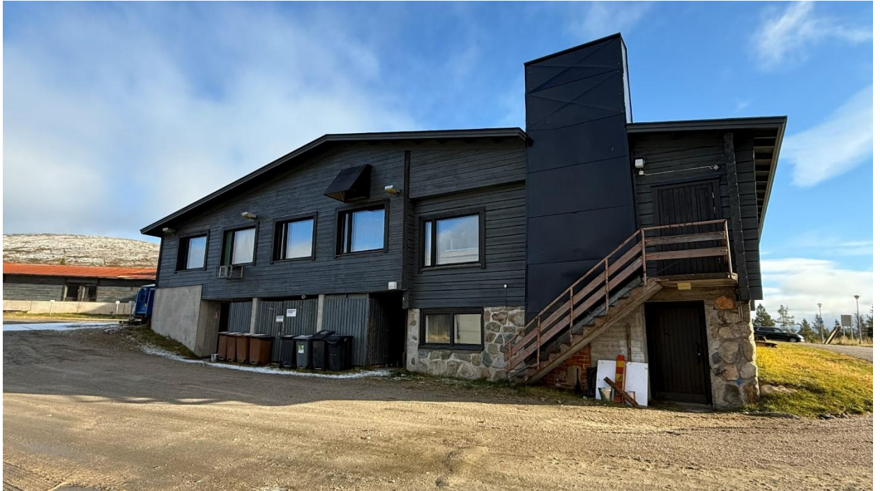
Päädyn kivetty sokkeliosa näyttää 1961 tehdyn ravintolan laajennusosan. 1988 päätyä laajennettiin ja runkosyvyyyttä kasvatettiin keittiömuutoksen vuoksi.
