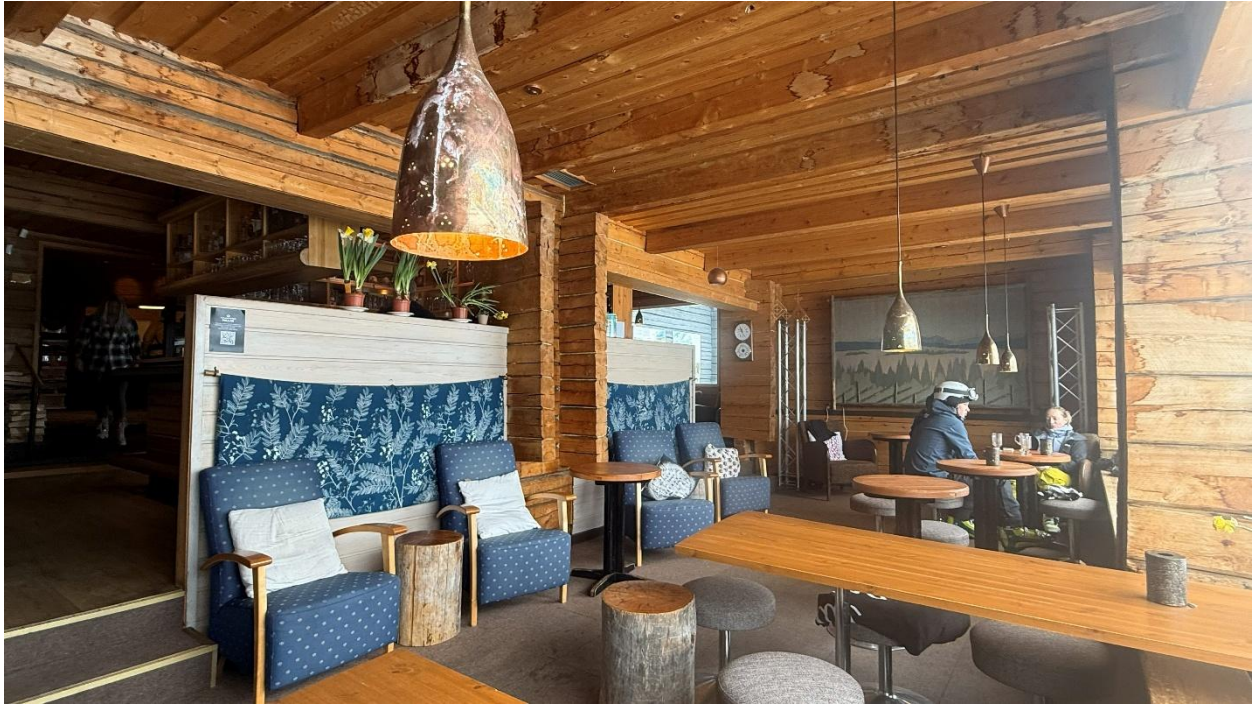
Baari. Kuvan keskellä oleva hirsiseinän osa on 1948 ulkoseinälinjaa. Sen takana 1988 tehty laajennusosa.
