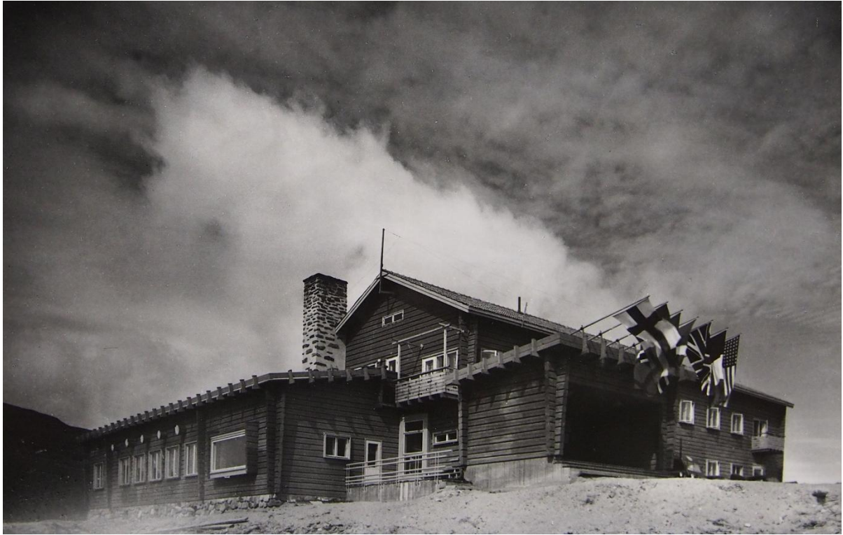
10. Pallaksen uusi hirsirunkoinen matkailumaja v. 1948. Matalaan siipeen sijoitettiin hotellin ruokasali ja kaksikerroksiseen päärakennukseen majoitushuoneet. Rakennuksen pääsisäänkäynti on katetussa syvennyksessä, jonka katolla oli turvekatto. Kuva: MFA.
