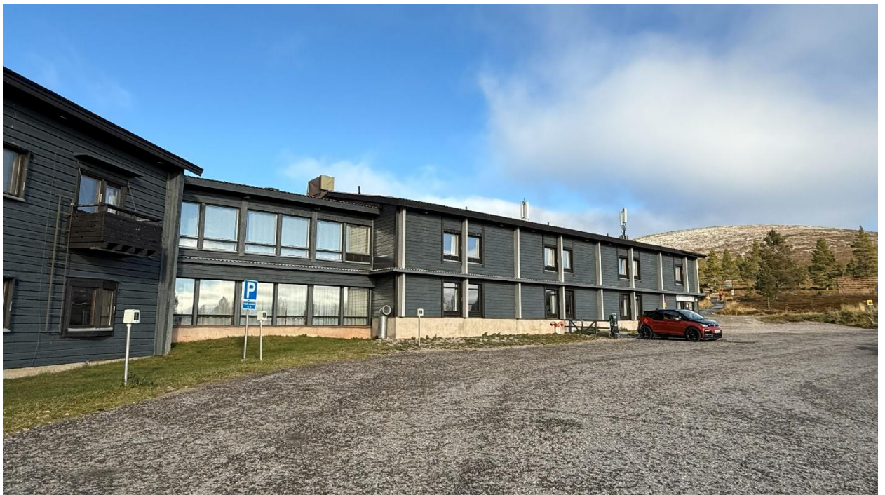
1988 tehty laajennusosa. Julkisivu etelään. Laajennuksen arkkitehtuuri vaatimaton, ajalleen tyypillinen.
